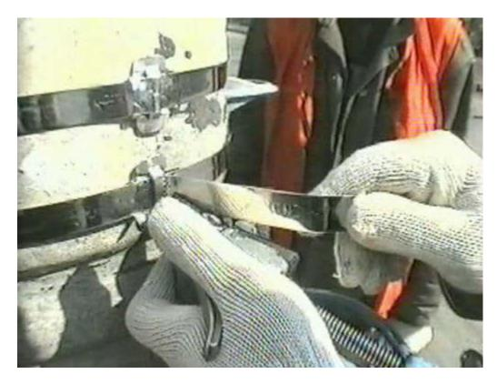
4. Вставить конец ленты в зажим машинки, зажать фиксатором.
